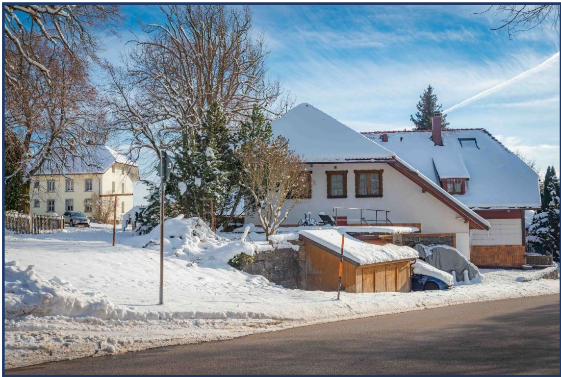
Haus - Außenansicht - Rückseite
